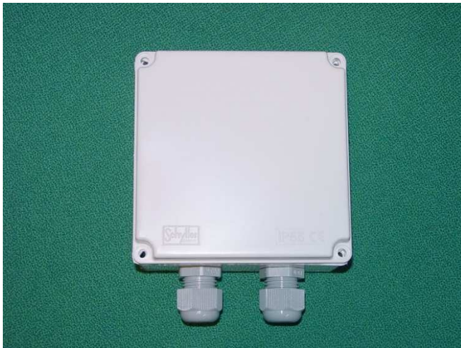
Kuva 4: Moottorin kondensaattorikotelo
