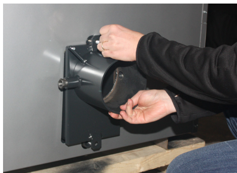
Asenna adapteri (savuputki) kahdella M10x60 pultilla kiinni kattilaan.
