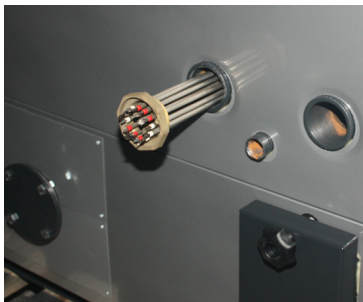
1. Sähkövastuksen asennus
