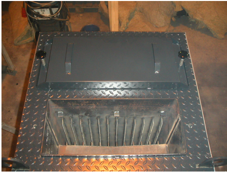
1. Avaa kattilan päällä olevat nuohousluukut.
