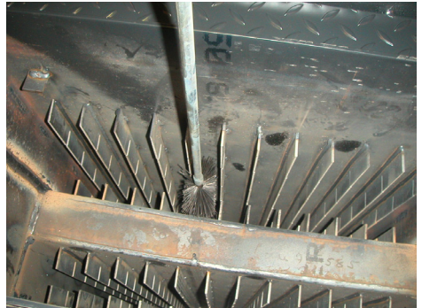
2. Kiinnitä harjaosa varteen ja harjaa sola kerrallaan.
