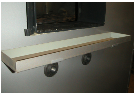
6. Tulipesä ei normaalisti vaadi erillistä puhdistamista. Oikein säädetty poltto pitää tulipesän puhtaana. Tuhkahylly asennettuna tulipesän luukun alle.
