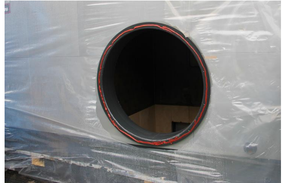
Kuva 3. Valmis silikonimassa kattilan poltinaukolla
