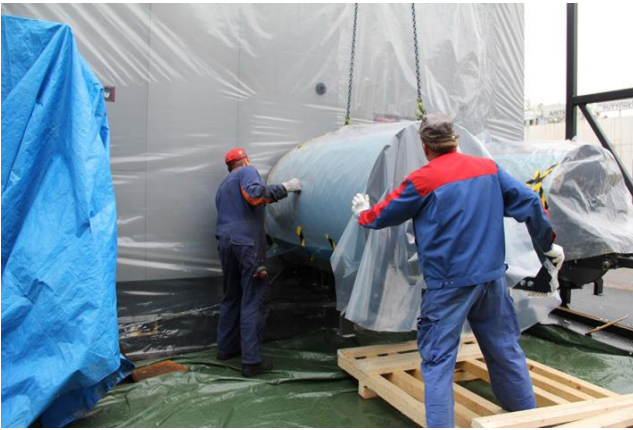
Kuva 5. Palopään asentaminen nostolaitteen avulla kattilan poltinaukkoon.
