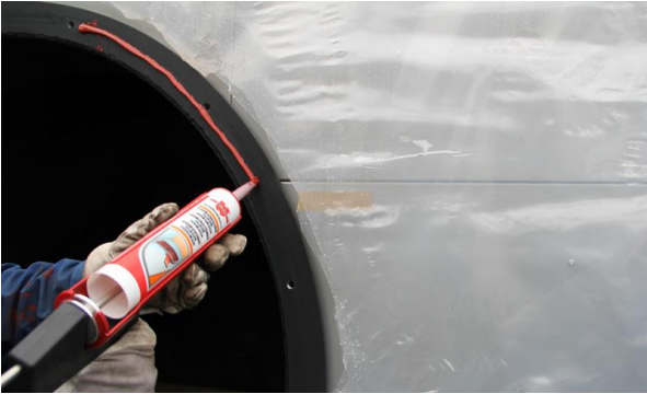
Kuva 4. Lämmönkestävän silikonin pursottaminen
