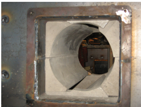
7. Sivutiilen yläosat 2 kpl (huom kätisyys). Väliaikainen tuki poistetaan, asennus on valmis.
