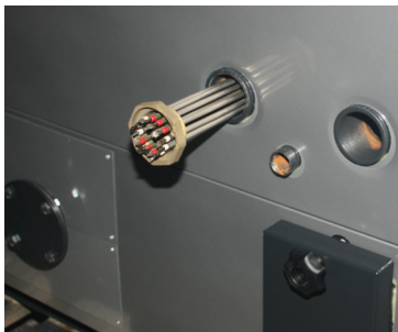
1. Sähkövastuksen asennus
