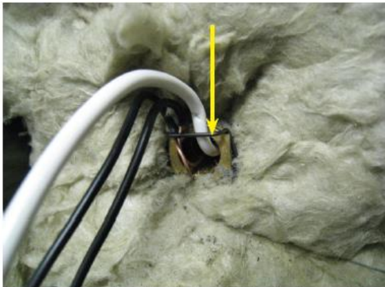
10. Asenna anturitaskun sokka ylhäältä päin, niin että sokka osuu sille tarkoitettuun uraan.
