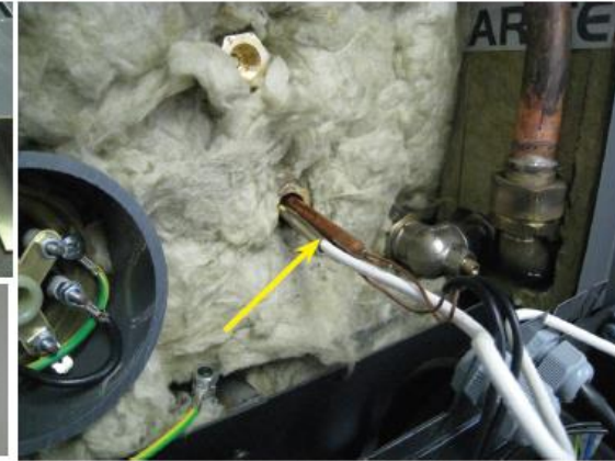
9. Työnnä anturit anturitaskuun. Anturit on oltava taskun pohjalla.
