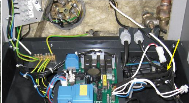
11. Kiinnitä johdot ja kappilaariputket nippusiteellä toisiinsa.
