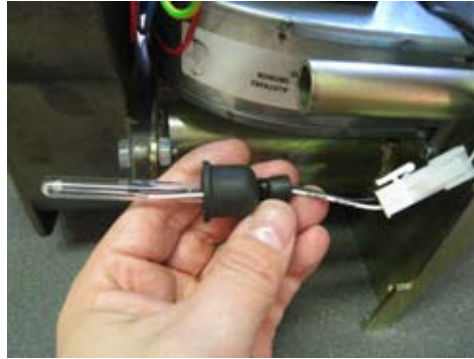
1. Irroita liekinvalvoja paikaltaan vetämällä kumisuojuksesta ulospäin.
