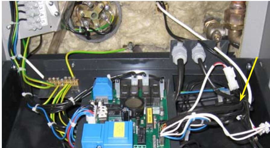
11. Kiinnitä johdot ja kappilaariputket nippusiteellä toisiinsa.
