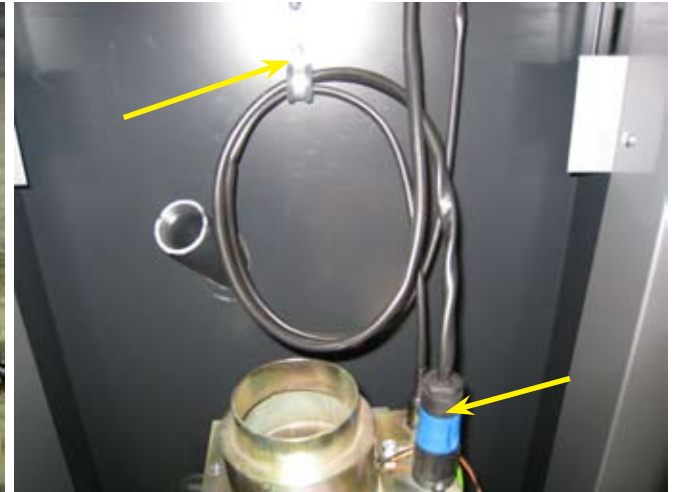
8. Irroita panelin johtojen kiinnitys kattilasta ja liittimet polttimesta.
